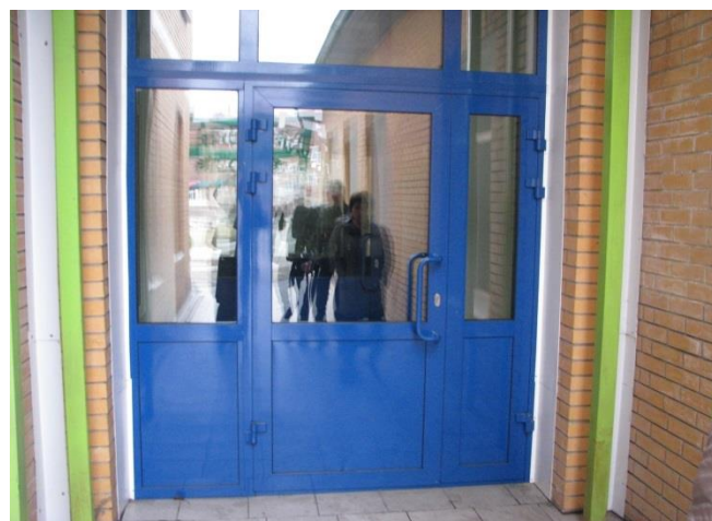
ФОТО 10 ВХОД В ЗДАНИЕ
