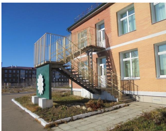
ФОТО 9 НАРУЖНЫЕ ЭВАКУАЦИОННЫЕ ЛЕСТНИЦЫ С ПОРУЧНЯМИ
