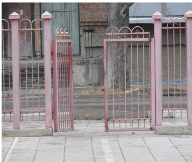
ФОТО 5 ЦЕНТРАЛЬНЫЙ ВХОД НА ТЕРРИТОРИЮ ДОУ
